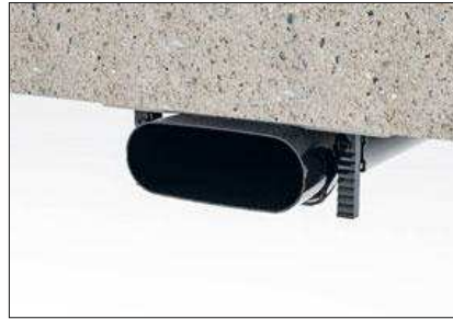
Flachkanal an der Kellerdecke
