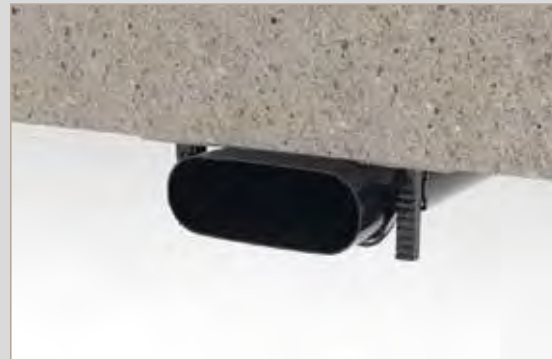
Flachkanal an der Decke
